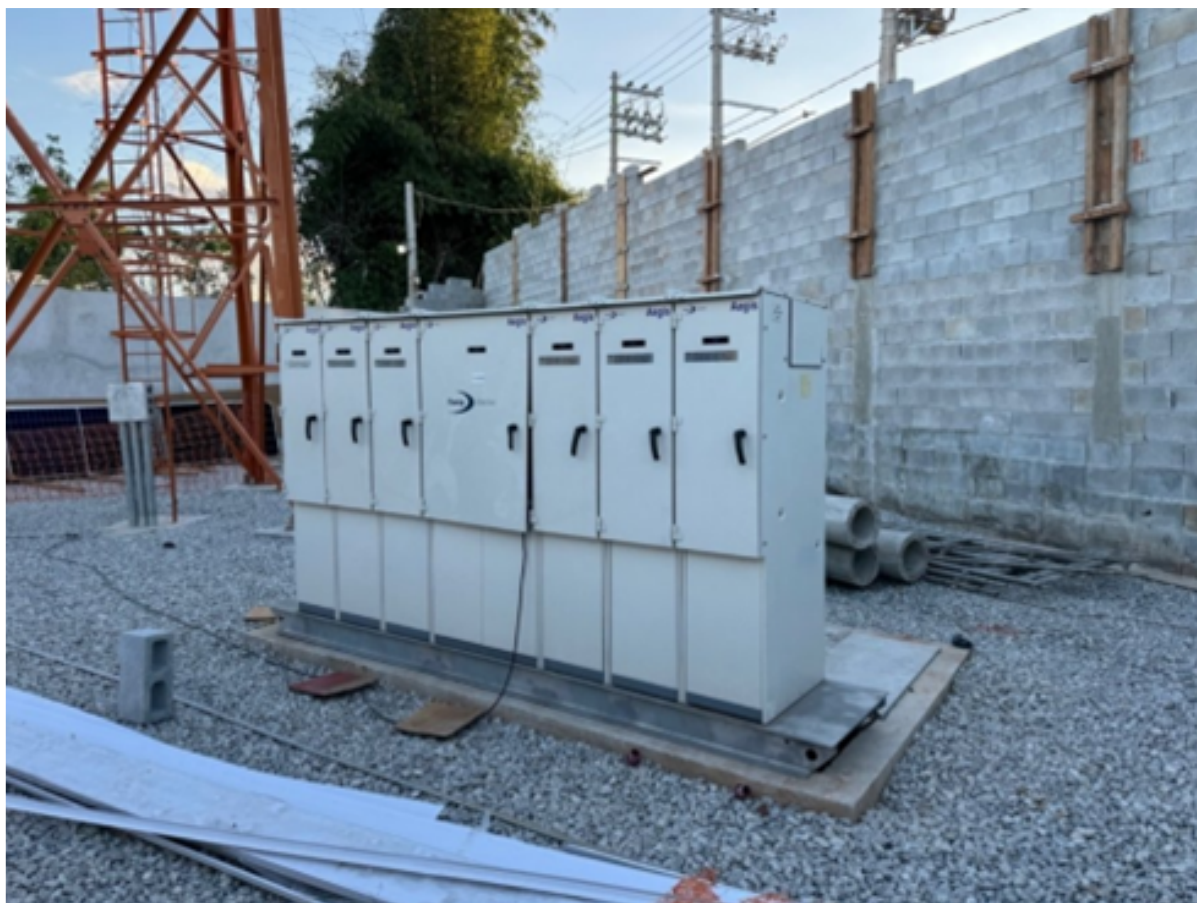
Figura 9 – Equipamentos que contribuem para a redução de custos de instalação nas soluções desenvolvidas pela EDP São Paulo – Equipamento conjunto blindado (cubículos) composto por secundários, interligação e alimentadores
