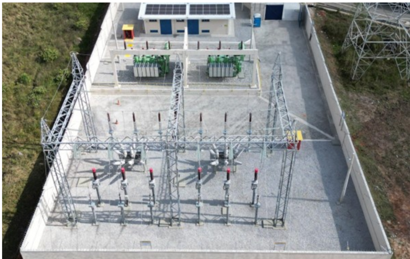
Figura 8 – Equipamentos que contribuem para a redução de custos de instalação nas soluções desenvolvidas pela EDP São Paulo – Equipamento de barra de transferência no bay de média tensão
